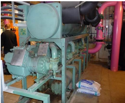
Abbildung 12 Eine von fünf Großkältemaschinen
