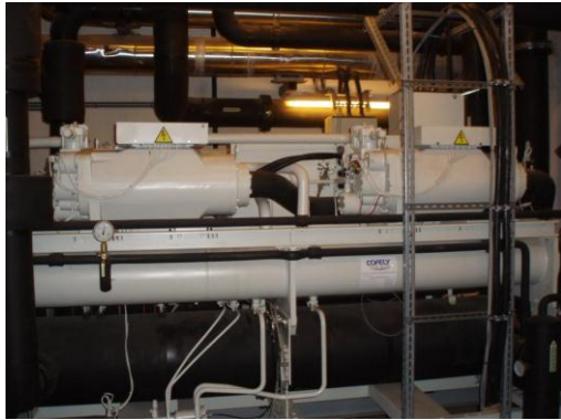
Abbildung 49 Großkältemaschine mit einer Kälteleistung von 531 kW (Foto: Österreichische Energieagentur, 2012)
