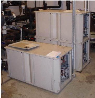
Abbildung 16 Blick auf die Kältemaschinen
