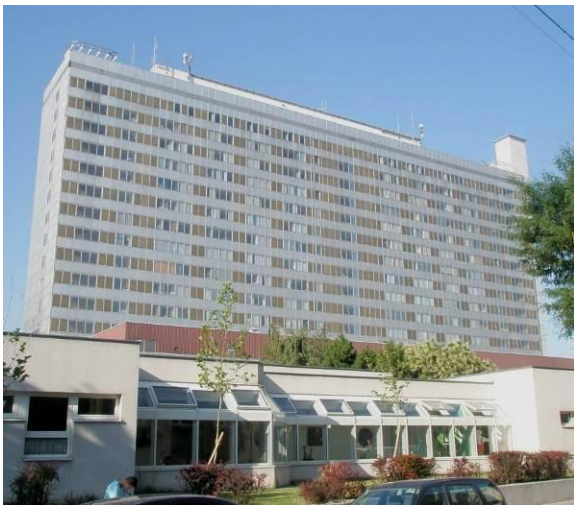
Abbildung 11 17-geschoßiger Hochbau der Rudolfstiftung
