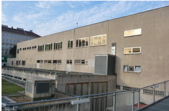
Abbildung 48 Westverbau der Rudolfstiftung (Foto: RMA, 2012)
