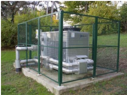
Abbildung 5 Kältemaschine des Pavillon 13
