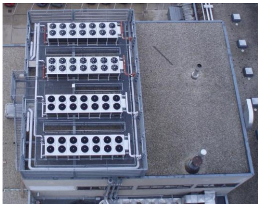
Abbildung 50 Free Cooling System des Westverbau (Foto: Österreichische Energieagentur, 2012)
